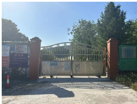
11月17日乾务水库现场踏勘照片
